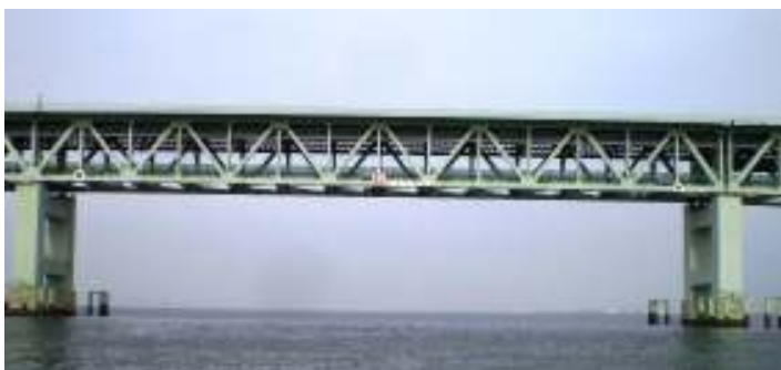
(写真 2)通過ゲート全体
