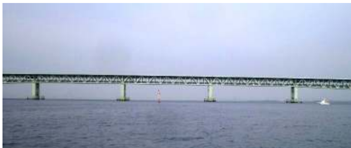
マーク1からコースの方向に見たゲートの写真 (写真 1)遠景
