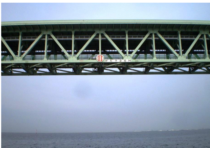
(写真 3) ゲート上部 赤色円に赤タテ線 2 本の標識 「けた下 25M」の標識
