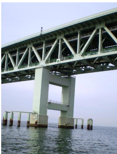
(写真 4・5) 右端に赤色三角形マーク 左端に緑色四角形マーク 橋脚下部に衝突防禦ネット
