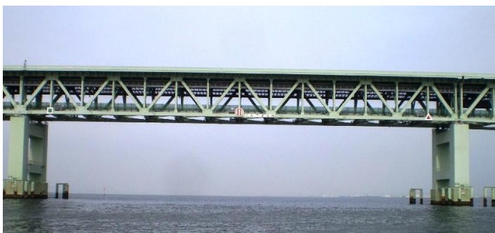
(写真 2) 通過ゲート全体
